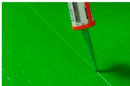
6. Die eingespritzte Fugenmasse wird unmittelbar nach dem Ausspritzen mit dem nora<sup>®</sup> Glättspatel in die Fuge gedrückt und eben abgezogen. Die überschüssige Fugenmasse wird dabei links und rechts neben die Fuge gedrückt. Es ist darauf zu achten, dass eine Trennung der Fugenmasse in der Fuge von dem zur Seite gedrängten Material erfolgt. Spatel möglichst flach halten, da sonst Hohlfugen entstehen.
