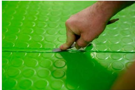
7. Die zur Seite gedrückte Fugenmasse kann nach ca. 12 Stunden entfernt werden.
