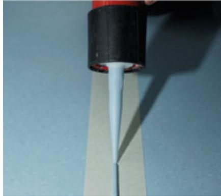
5. Die eingespritzte Fugenmasse wird unmittelbar nach dem Ausspritzen mit dem nora<sup>®</sup> Glättspatel in die Fuge gedrückt und eben abgezogen. Die überschüssige Fugenmasse wird dabei links und rechts neben die Fuge gedrückt. Spatel möglichst flach halten, da sonst Hohlfugen entstehen.
